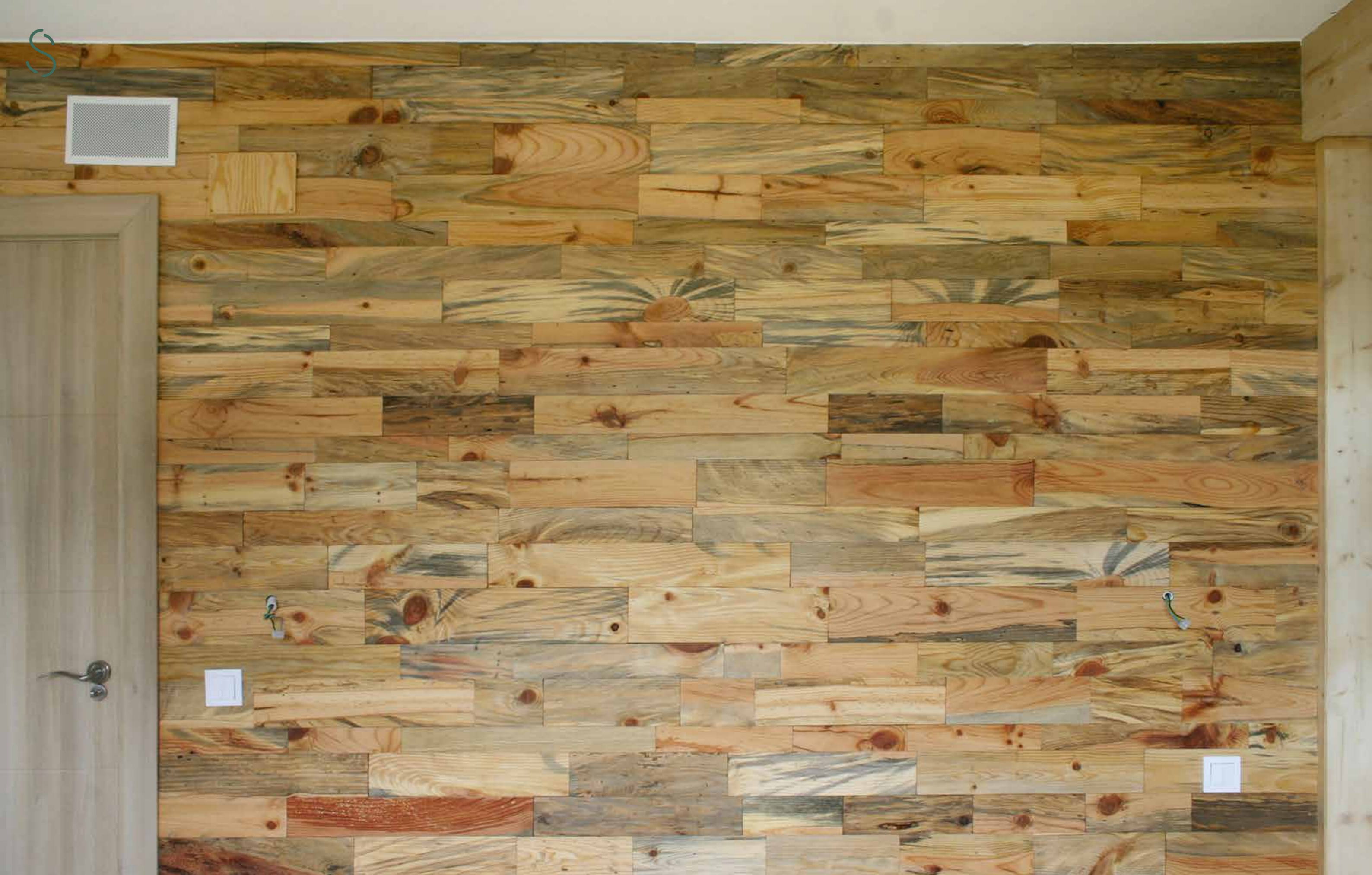
Wandverkleidung aus Kiefernholzlatten.
